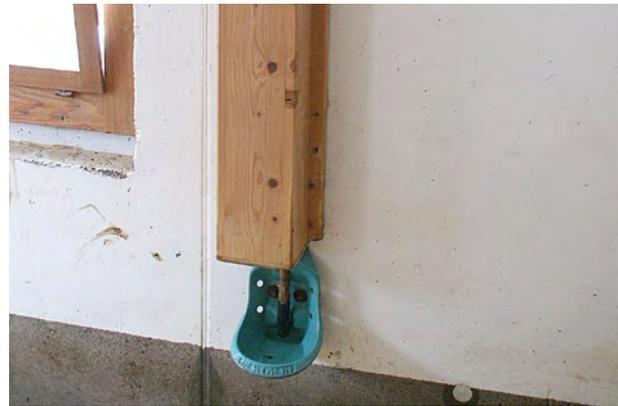
*Die Wasserleitungen sind vor Kälte geschützt und mit Heizschlangen umwickelt.*
