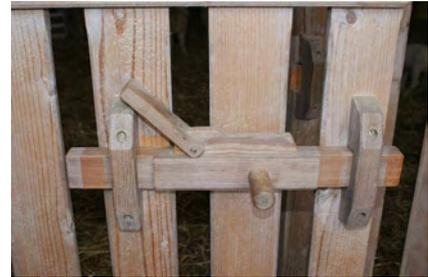
*Türriegel mit Sicherung.*
