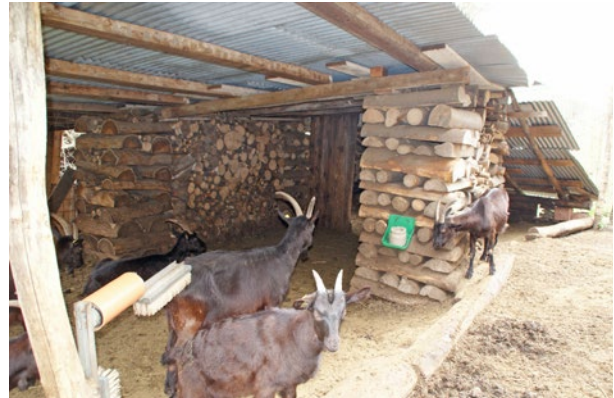
Holzbeigen als Dachstützen
