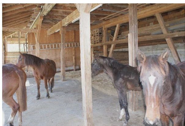
La stalla è suddivisa solo dai sostegni del tetto.
